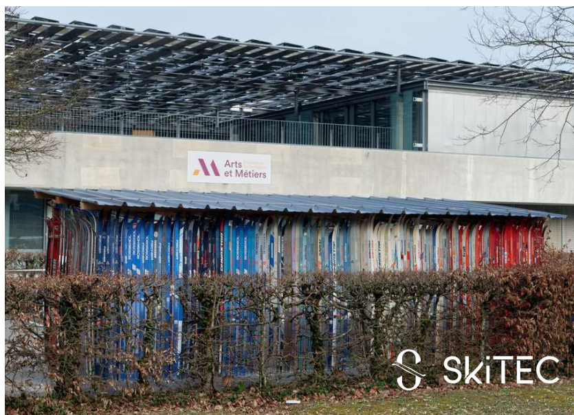
Le bardage en skis de cet abri reproduit les bandes du réchauffement climatique du Pr. Hawkins.
